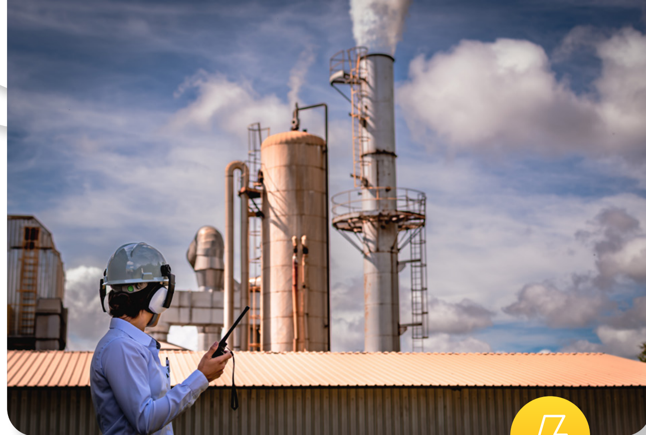
Caldeira à Vapor, unidade Araxá
