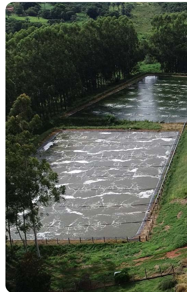
Estação de Tratamento de Efluentes Unidade Araxá (MG)
